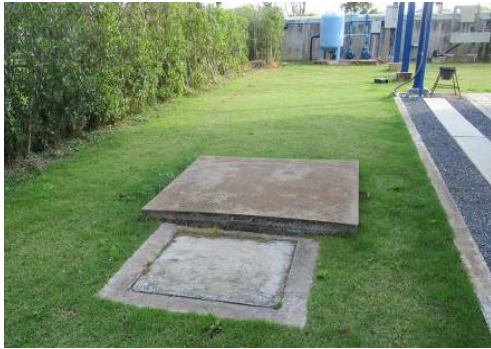
ภาพที่ 2-13 ป่อกระโหลกหรือถังบำบัดน้ำเสียสำเร็จรูป
