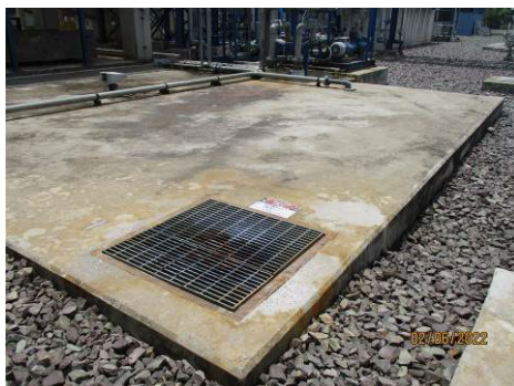
ภาพที่ 2-20 บ่อปรับสภาพความเป็นกรด-ด่าง (Neutralization Pit)
