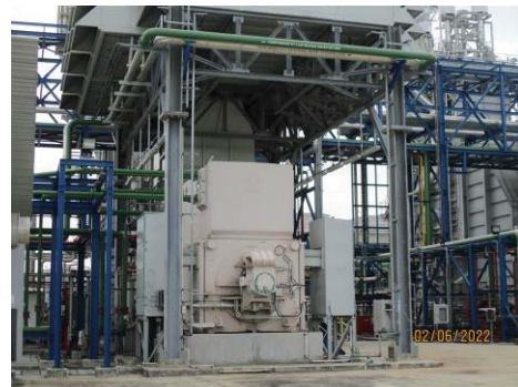
ภาพที่ 2-6 อาคารคลุมเครื่องจักรที่มีเสียงดัง
