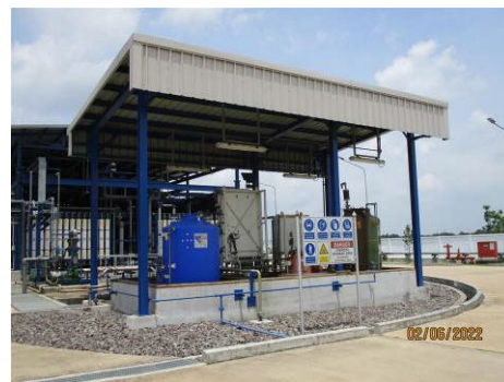
ภาพที่ 2-48 อาคาร/แทงค์จัดเก็บสารเคมีอันตราย
