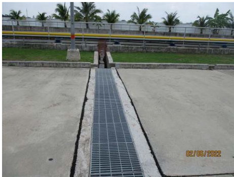
ภาพที่ 2-29 ระบบรวบรวมน้ำฝนและท่อระบายน้ำของโรงไฟฟ้า
