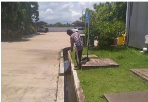
ภาพที่ 2-31 การทำความสะอาดทางระบายน้ำในพื้นที่โรงไฟฟ้า
