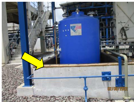
ภาพที่ 2-55 คันกั้น (Dike) บริเวณสถานที่เก็บสารเคมี
